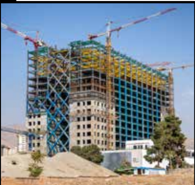
Стальные конструкции больницы «Саламат Баркат»
