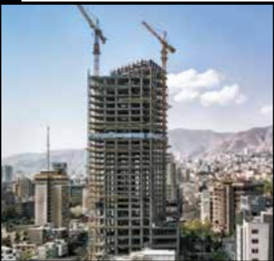
Стальной каркас проекта гостиницы «Мелал»
