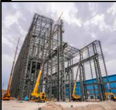
Стальной каркас литейного завода Комплекса «Сепид Фараб Кавир Стил»
