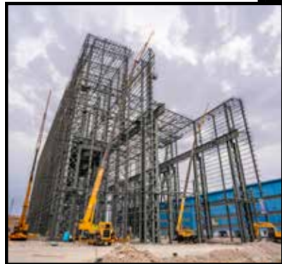
..... [ الهيكل المعدني لمصنع الصهر - مجمع إنتاج فولاد سيد فراب كوير ]
