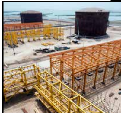
..... [ الهياكل المعدنية لمشروع مصفاة غاز بيدبلند الخليج الفارسي ]
