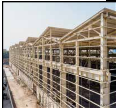
..... [ الهيكل المعدني لصاله بريس شوب ٢ - شركة تصميم وتصنيع قطع خبار صناعات إيران ]
