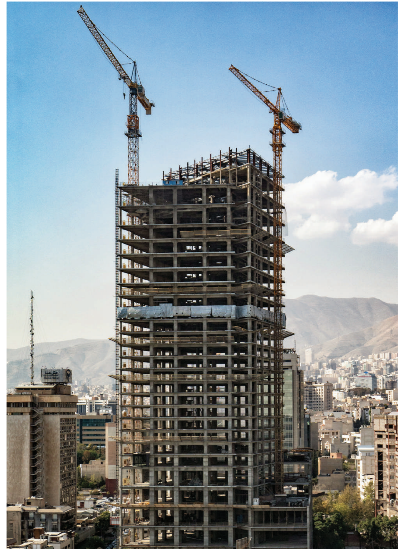
• ساخت سازه‌های فلزی پروژه هتل ملل | ۱۶۰۰۰ تن
