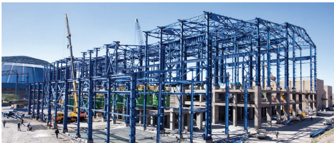
• سازه فلزی سالن اصلی پروژه معدن سنگ آهن سنگان | ۴۰۰۰ تن
