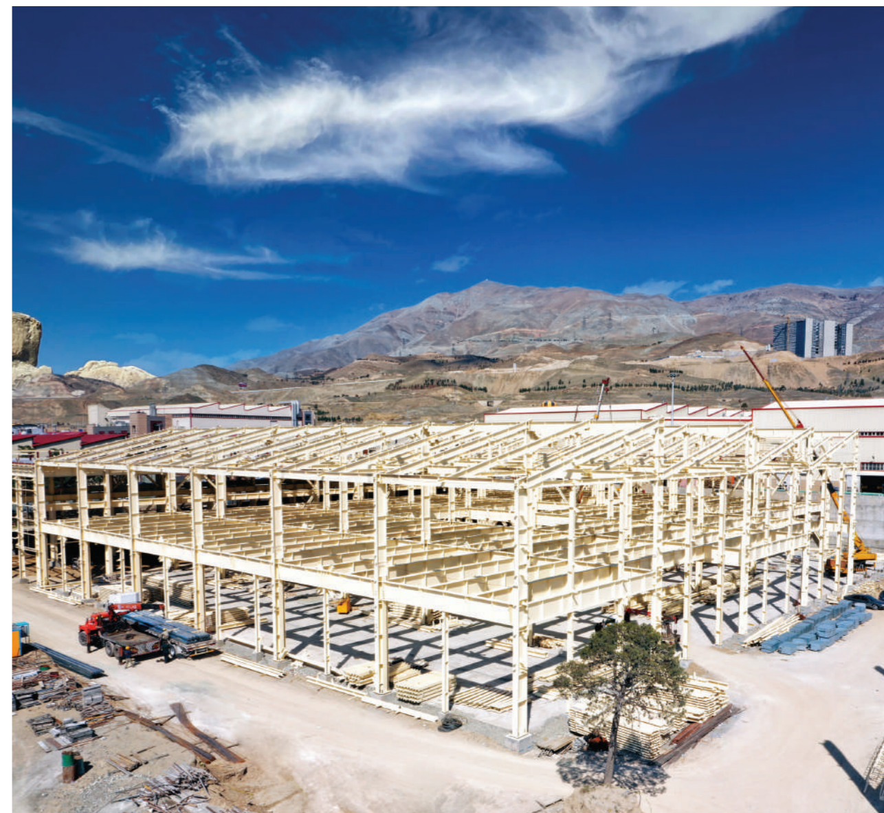
• سازه سالن‌های جنوبی سایت شماره ۳ شرکت کروز | ۱۱۰۰۰ تن
