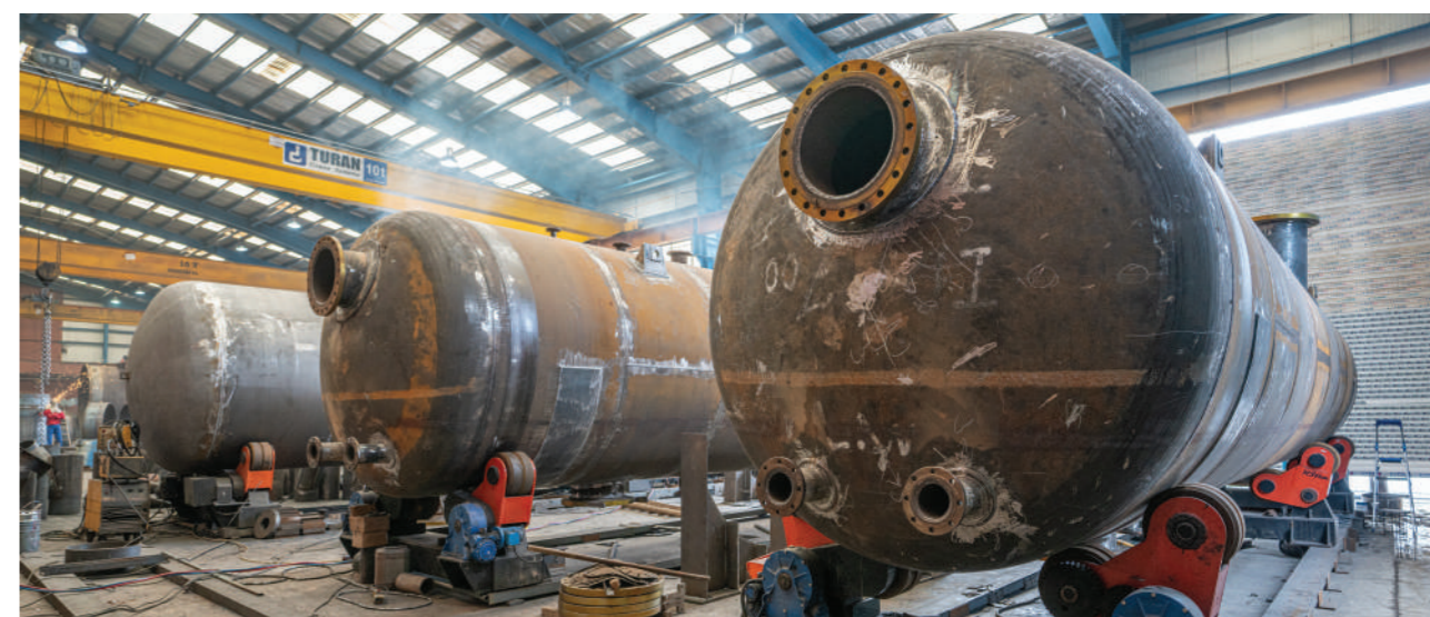
• پروژه ساخت فیلترهای شنی پروژه آب شیرین کن بندرعباس | ۷۰۰ تن
