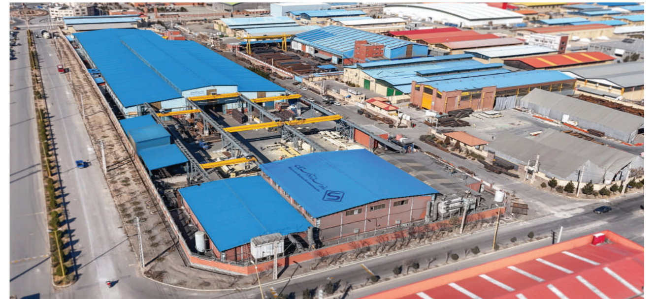
• کارخانه شرکت سازوسازه آذرستان
