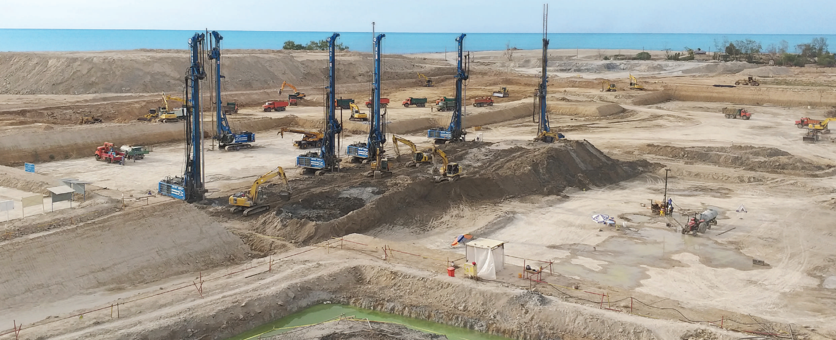
• پروژه تحکیم بستر بوشهر
