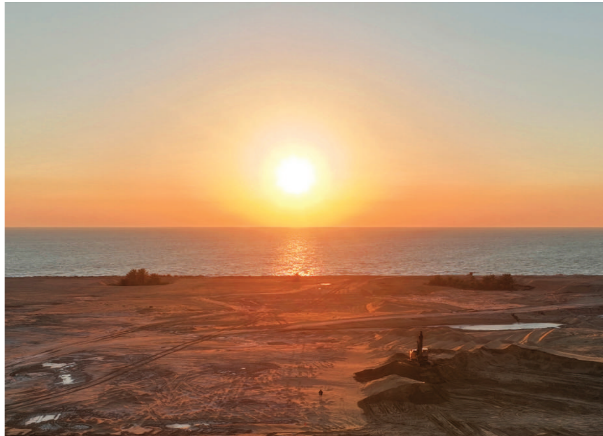
• پروژه نیروگاه حرارتی سیریک
