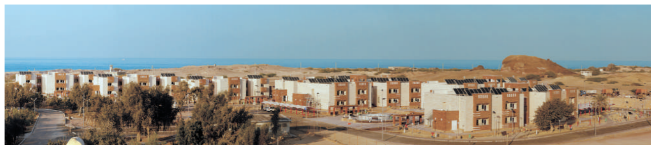
• ساختمان‌های مسکونی کوی نصر در جزیره سیری
