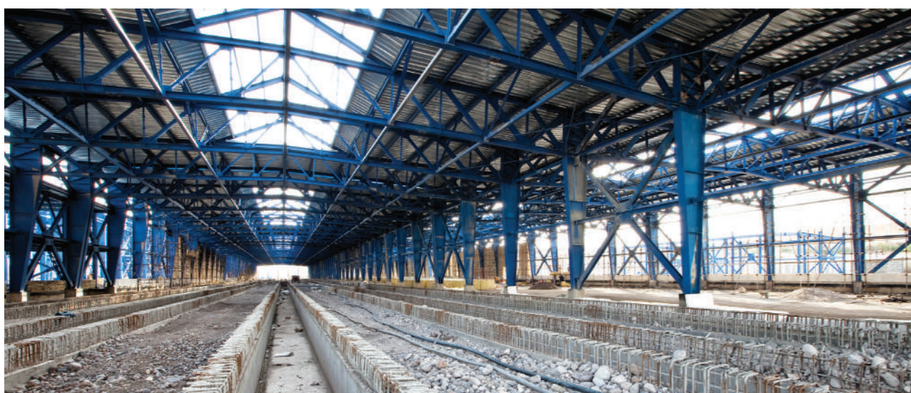
• پروژه سازه فلزی سالن‌های صنعتی دیپوی لاله (مترو تبریز) | ۴۰۰۰ تن
