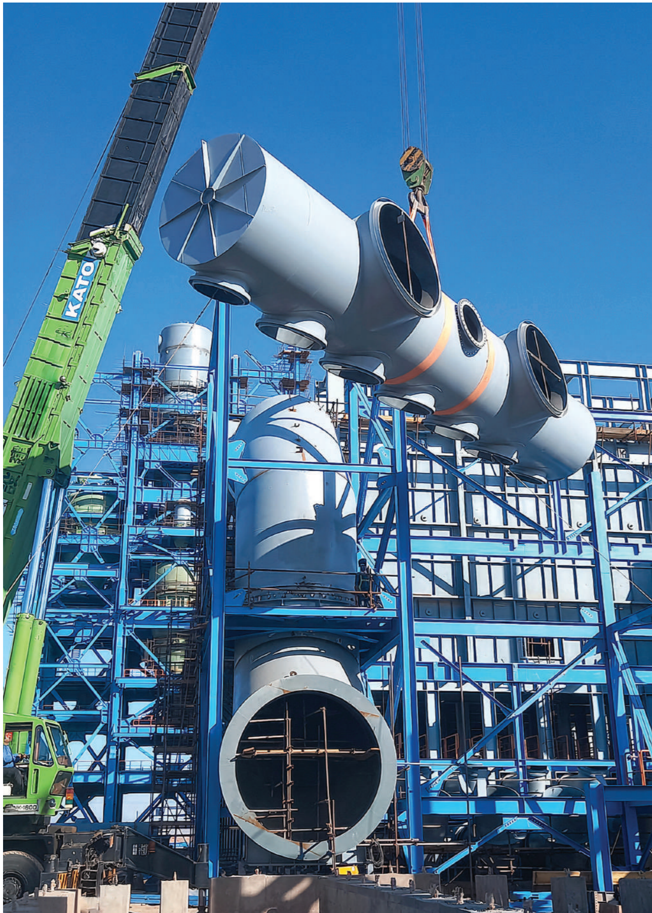
• داکت‌های پروژه واحد احیای مستقیم آهن اسفنجی تربت‌حیدریه | ۷۰۰ تن
