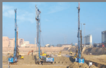
پروژه تحکیم بستر بوشهر
