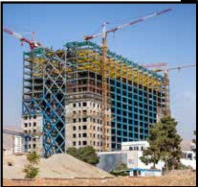
..... [اسکلت سازه فلزی بیمارستان سلامت برکت]
